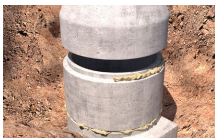
Sigillatura anelli di pozzetti di calcestruzzo.
